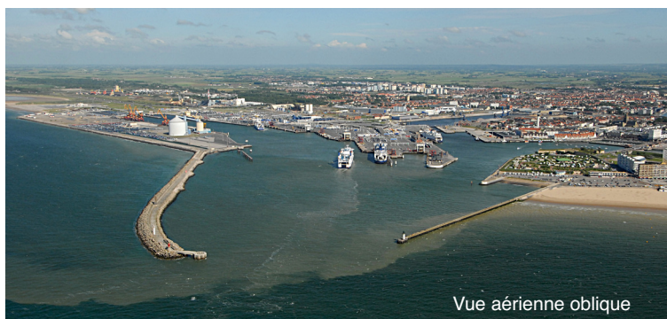
10.4.4.C. — Entrée de port, vue de la passerelle et vue oblique.
