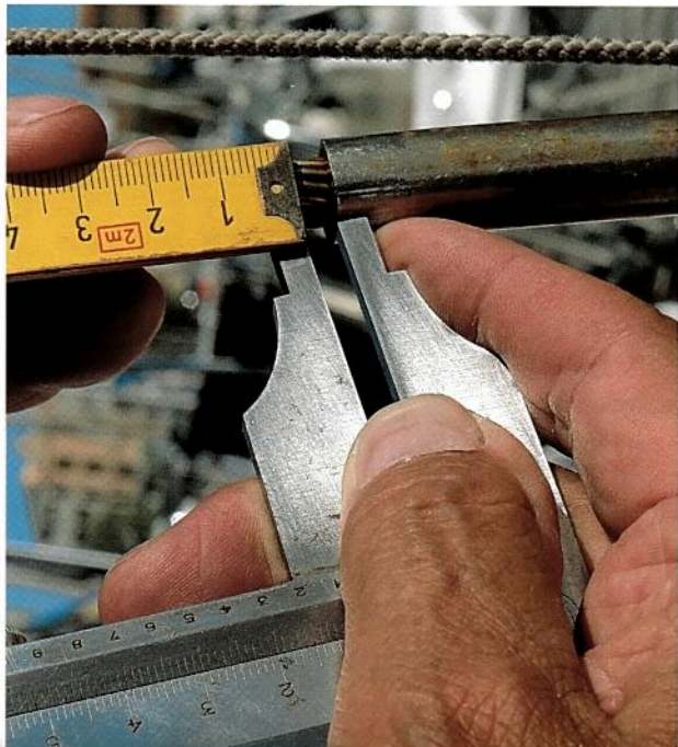
Dès que le câble est sous tension, son allongement se matérialise par un décalage que l'on mesure au pied à coulisse, entre le mètre et le manchonnage.
