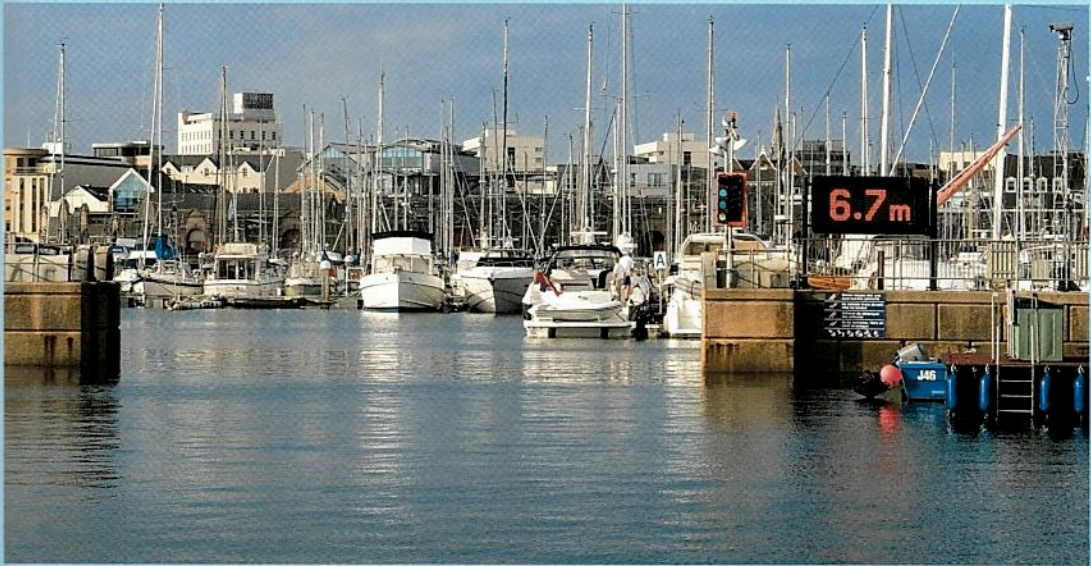
Marina de Saint-Hélier (Jersey) : les feux de trafic (ici deux feux verts sur un feu blanc) indiquent que les bateaux peuvent passer mais que le trafic est à double sens. S'agissant d'une porte à seuil, le niveau d'eau est également affiché (6,70 m).
