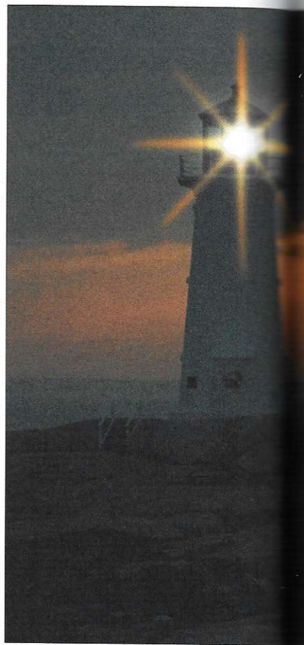
La mise en route des signaux lumineux émis par les phares s'opère à l'heure du coucher du soleil, et l'extinction à son lever.
